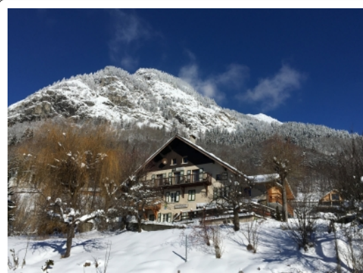
Bâtiment typique de l'Oisans
