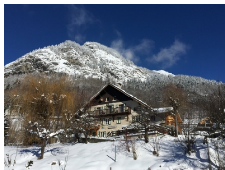
Bâtiment typique de l'Oisans
